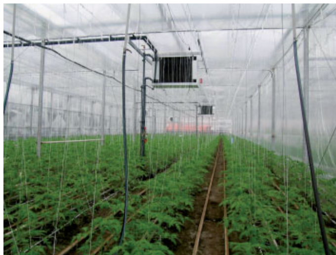
Figuur 3. overzicht proefkas met luchtbehandelingskasten.
