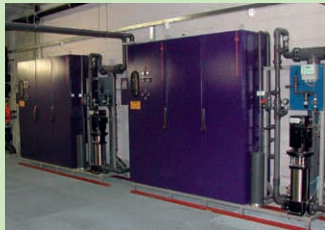
De installatie zoals Excellent Ozone Systems BV deze tegenwoordig maakt (foto Excellent).
