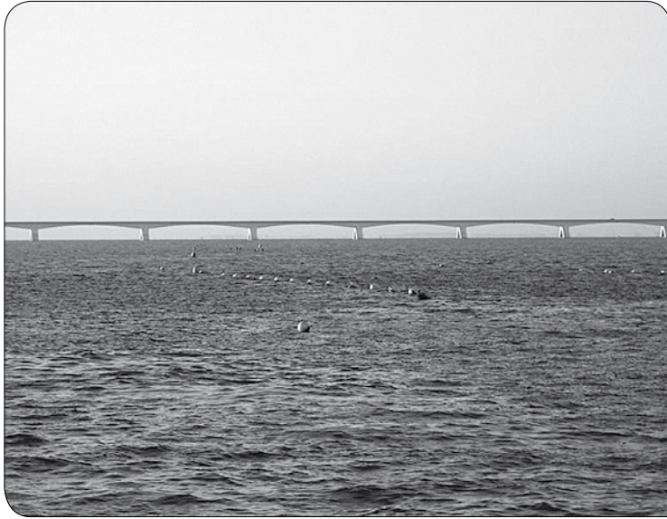
Het Emergo project van M. en M. Padmos in de Oosterschelde.
