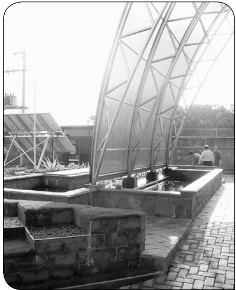
Waterval op de technisch school te Surakarta (Midden-Java). De energie voor de waterpomp is afkomstig van het zonnepaneel op de achtergrond
