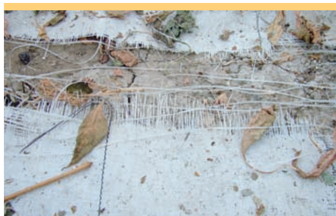
Voor het vervangen van het gronddoek moeten alle buizen omhoog.
