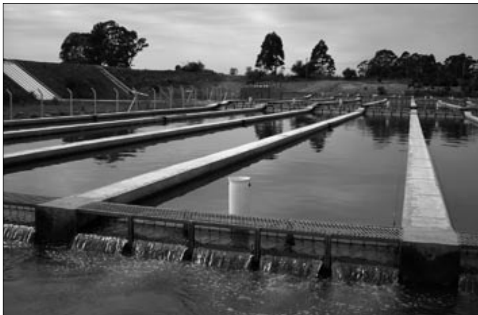
Raceway systeem in Steurkwekerij Rio Negro S.A.
