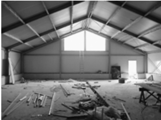
De centrale hal werd aan de zuidkant voorzien van een raam. In de vloer is een goot naar buiten voor de afvoer van effluent
