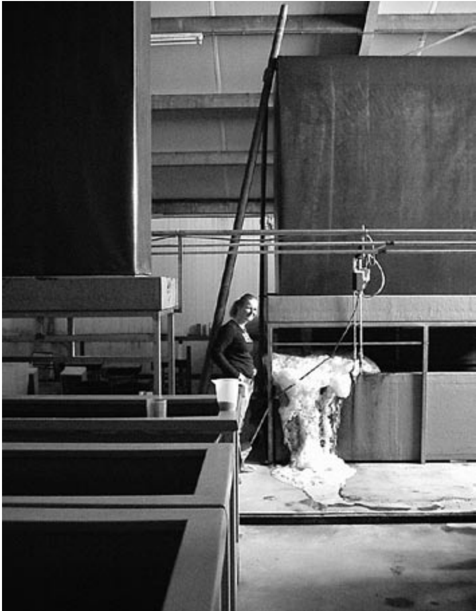
Het biofilter in bedrijf. De bassins en biofilters werden (direct of indirect) geleverd door installatiebureau Fleuren en Nooyen. In de vloer: de goot voor de afvoer van slib en teeltwater.
