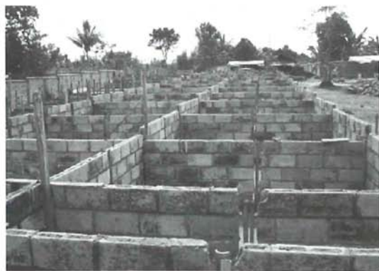
Gepland: 40 visbassins van beton van elk 3 bij 2 meter, in aanbouw. Rechts achter: gebouwen voor visverwerking, eveneens in aanbouw.
