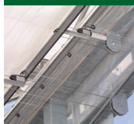
Stevige balken en dito omkeerwielen voeren de krachten van de trekdraden af naar de kop-gevelkolommen.
