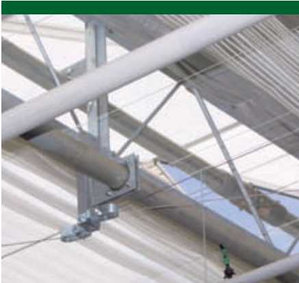
De aandrijf-as van de scherminstallatie wordt naar twee tegenovergestelde kanten geschoord.
