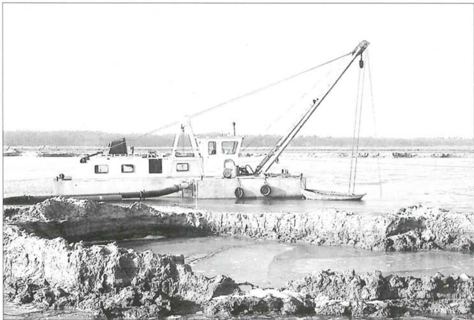
◆ Boot met zandzuiginstallatie in de forellenvijver in statu nascendi.
