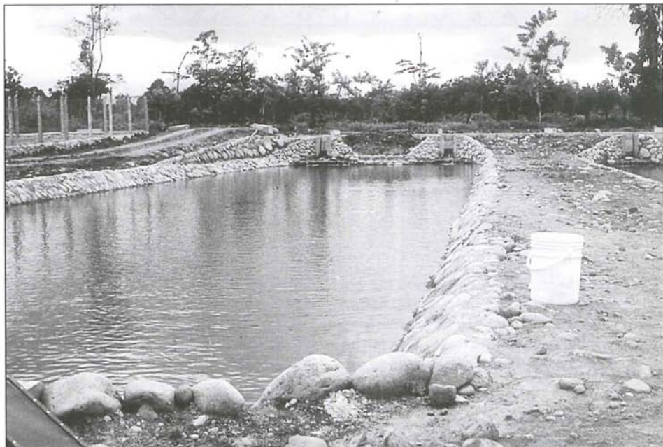
♦ Een nieuw gegraven visvijver met betonnen oevers
