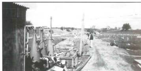
◆ Zuurstofcone's voor injectie van zuurstof wat nodig is omdat het water meerdere keren in de kwekerij wordt gerecirculeerd alvorens het de kwekerij verlaat.
