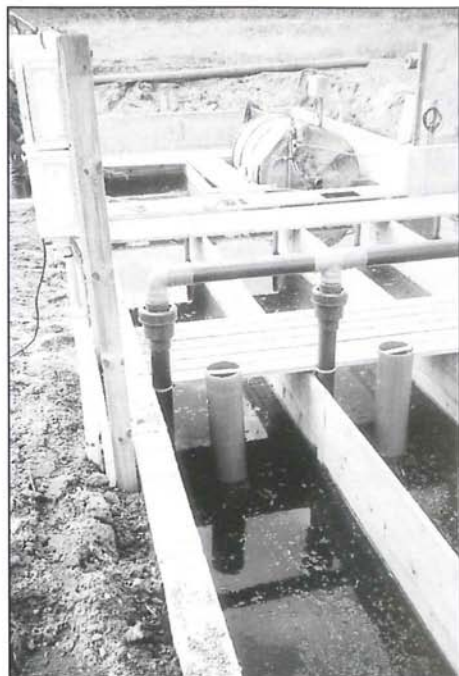
◆ Close-up biofilter, het water wordt verrijkt met zuurstof in een grindbedding onder in de kanaaltjes geïnjecteerd.
