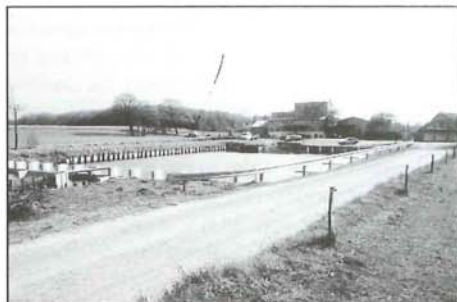
◆ Voorbeeld van een bezinkvijver die de laatste tijd speciaal aangelegd moet worden i.v.m. bovengenoemde milieueisen.
