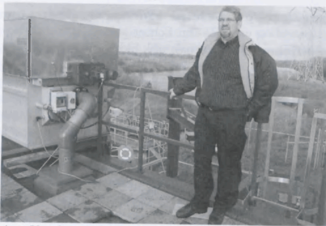
Aart Verschoor boven op de installatie.
