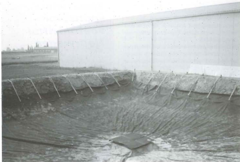
◆ Naast de kwekerij is een slibopslag voor de palingmest gemaakt.
