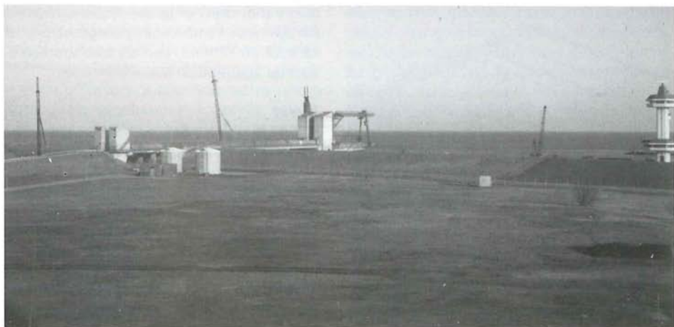
◆ De bouwlocatie van de nieuwe tarbotkwekerij aan de Eemshaven (foto DAE).
