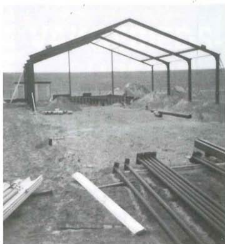
◆ De eerste stalen spanten voor de zeeviskwekerij staan overeind (foto DAE).
