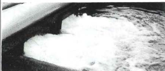
LP AERATORS in gebruik
