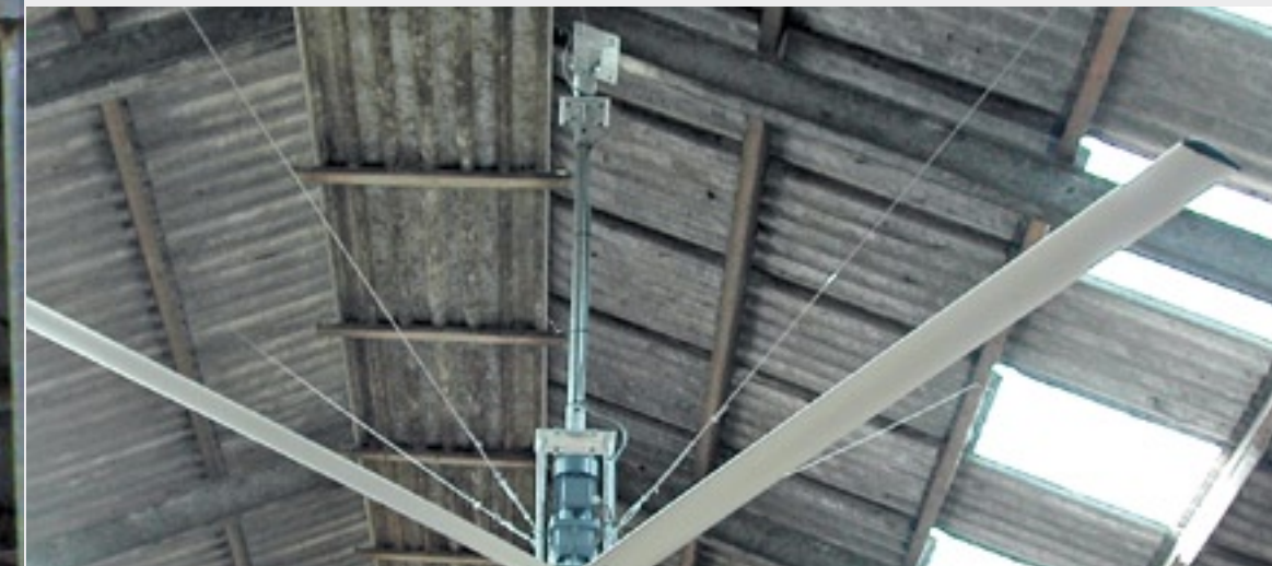
De ventilator hangt met een buis aan de spant van de stal.
