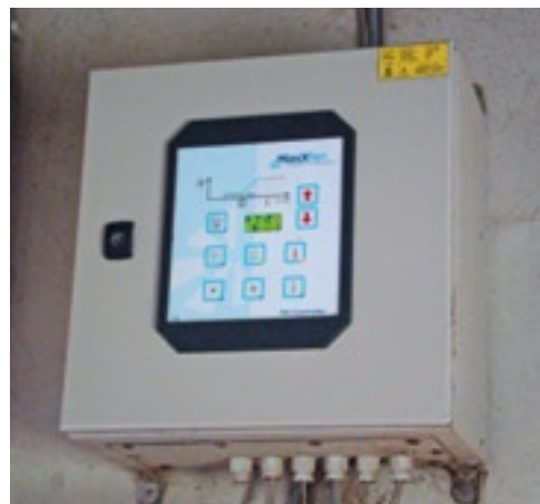
De bedieningskast van de HVLS-ventilator is eenvoudig te bedienen en is te koppelen aan een klimaatcomputer.
