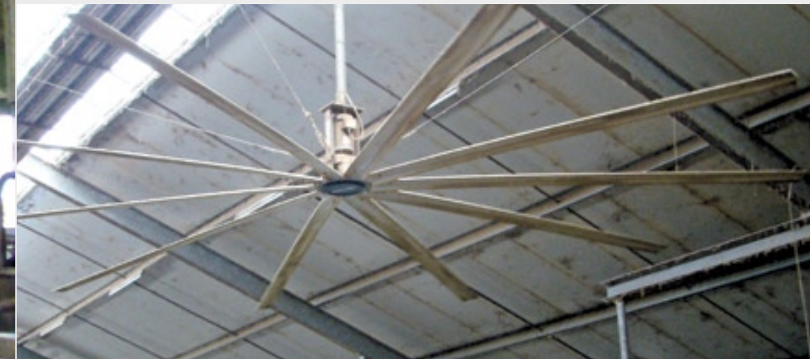
Vier tuikabels zorgen ervoor dat de ventilator ook bij vol vermogen stabiel blijft hangen en voorkomen dat de rotor met bladen naar beneden kan vallen.
