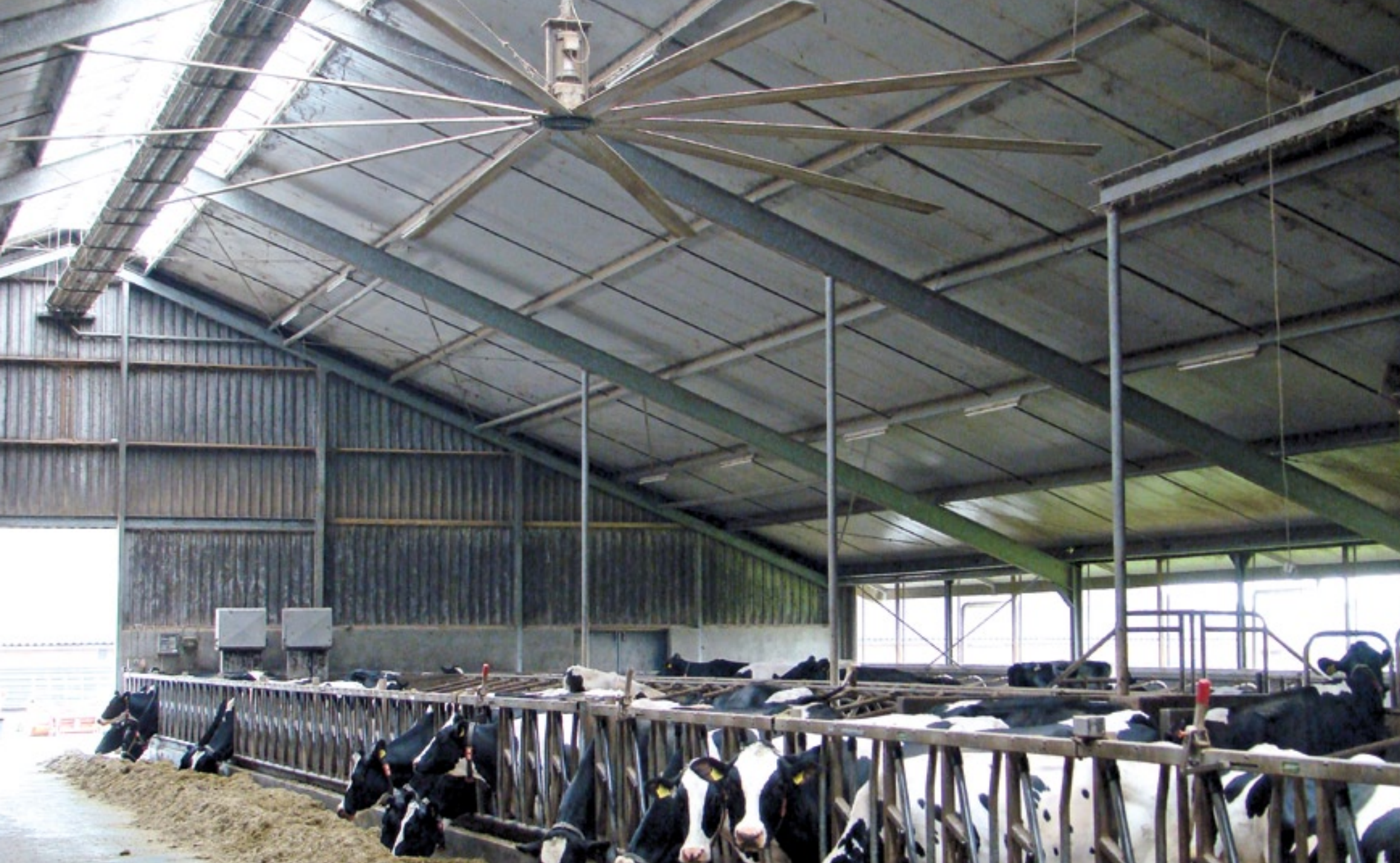
De ventilator hangt met een buis aan de spant van de stal.
