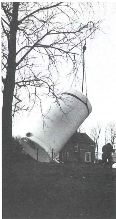
Het plaatsen van de nieuwe filters.
