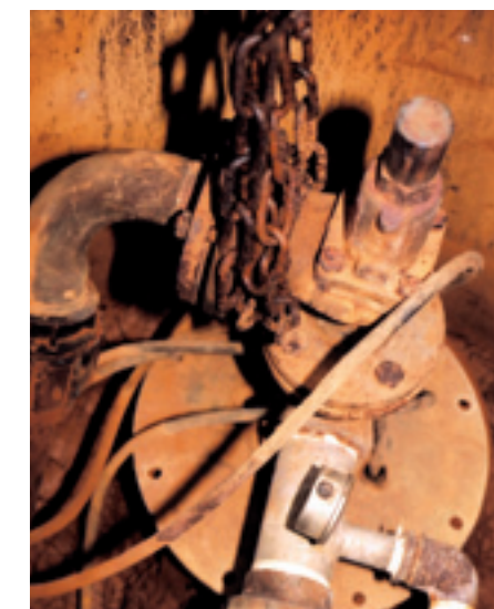
Een bron zonder watermeter is inmiddels niet meer voor iedere golfbaan realiteit. Behalve de te onttrekken hoeveelheid is ook de kwaliteit van het water een belangrijk punt. IJzerhoudend water zoals bij deze bron (foto rechts) is in ieder geval makkelijk te herkennen.
