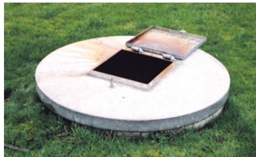
Een bron zonder watermeter is inmiddels niet meer voor iedere golfbaan realiteit. Behalve de te onttrekken hoeveelheid is ook de kwaliteit van het water een belangrijk punt. IJzerhoudend water zoals bij deze bron (foto rechts) is in ieder geval makkelijk te herkennen.
