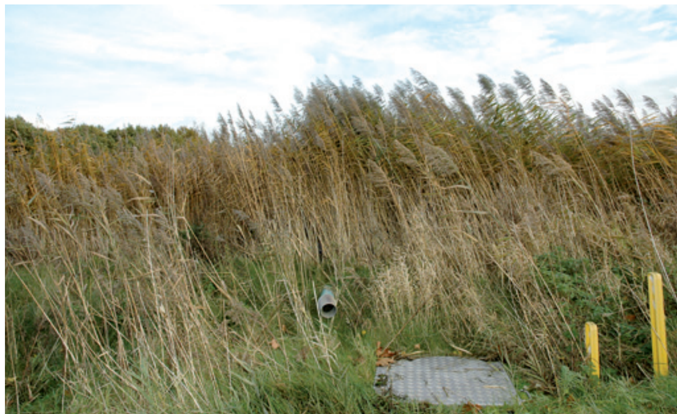
Aan het helofytenfilter op de Efteling is eigenlijk weinig te zien. Het is niet meer dan een rietveld. Dat is verdeeld in vier delen en er liggen buizen in die het water over het veld verdelen. Dat zakt vervolgens door het zandpakket terwijl de wortels van het riet hun zuiverende werking doen.
