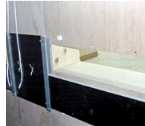
▲ Door het klepje in een perswand verder dicht te doen is de luchtverdeling sterk te verbeteren.
