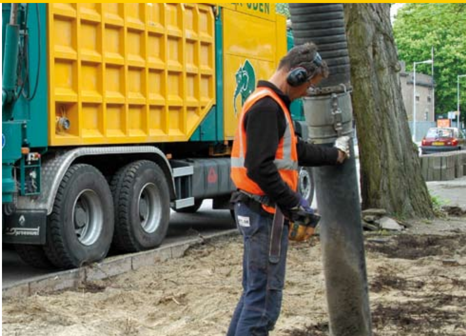
Eerst zuigt de grondzuigmachine het oppervlakkige wortelpakket vrij, daarna zuigt die het haarwortelpakket in een hogere stand schoon en vervolgens zuigt het ook de wortelpijlers.
