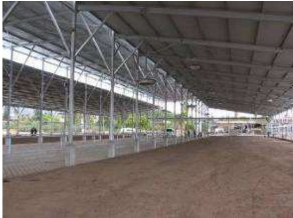
Foto 2 De ondergrond van de stal bestaat uit grit en moet stevig en ademend zijn (Bron: Sprecher)
