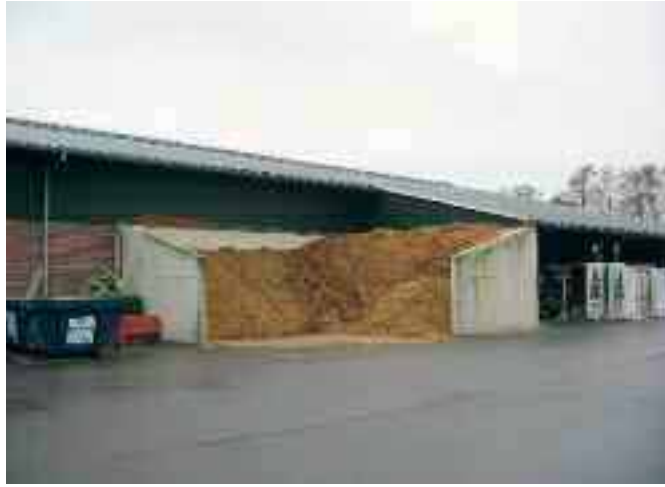
opslag ondergebracht onder de kap (Hemmelhorst Sporthorses, Borne)
