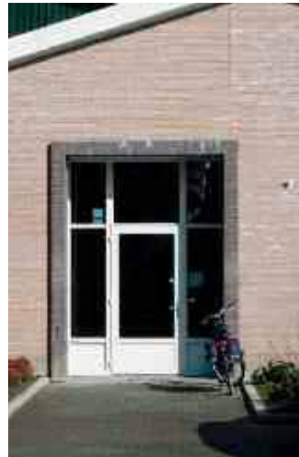
(bescheiden) markering entree geeft allure (paardencentrum Dronten)
