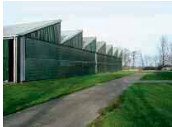
Sheddakstallen bron: Het Oversticht
