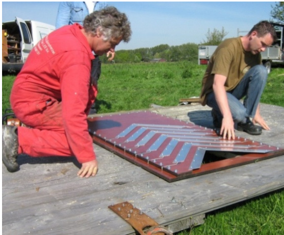
1) Plaatsing van het meetschot (met 7 V-notch niveaus) in het stroomopwaartse schot.
