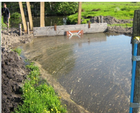
6) Na enkele dagen is het slootpeil gestabiliseerd en het hoge peil bereikt.
