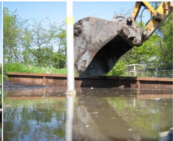
4) Vervolgens is het stroomafwaartse (noordelijke) schot geplaatst. Hierin is geen meetstuw geplaatst.
