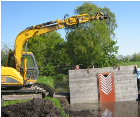
3) Bij plaatsing stond de v-notch met 7 segmenten op het hoogste niveau.
