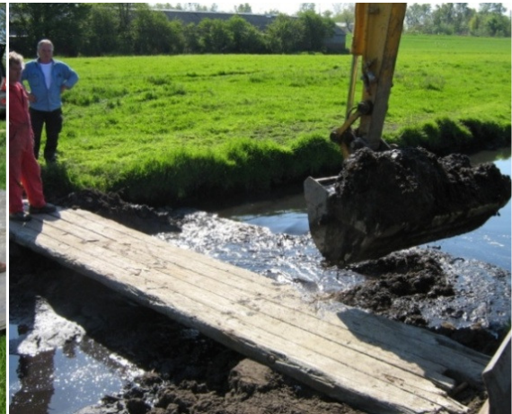
2) Plaatsing van het stroomopwaartse schot in de sloot.
