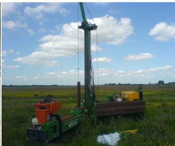
8) Zowel in de pleistocene zanden als in de holocene deklaag zijn peilbuizen geplaatst. In 6 peilbuizen zijn drukopnemers geplaatst.
