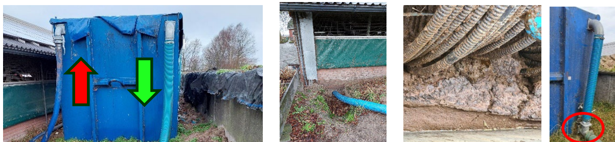
Figuur 5 Van links naar rechts: (1) instroom (rode pijl) en uitstroom (groene pijl) van de mestcontainer. (2) Instroom gekoelde mest langs de stalmuur in de kelder. (3) Het bezinksel op de bodem van de mestcontainer. (4) Impressie van afvoeropening onderaan de container (rode ellips).
