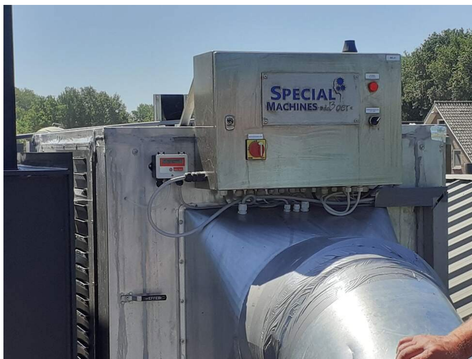
Figuur 2. De ammoniakfilter van Special Machines de Boer, die is geïnstalleerd op het leghennenbedrijf Bertens Poultry in Haghorst (Stal & Akker, 2021).
