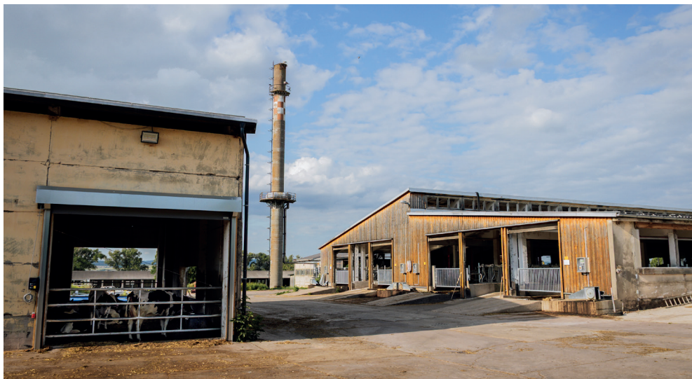
De gebouwen zijn van buiten niet veranderd, maar van binnen gemoderniseerd
