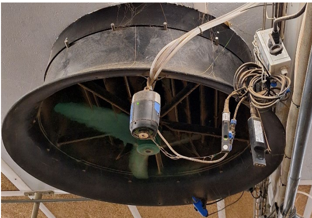
Figuur 8 SlimmeStal sensor set (foto bron: Van Assendelft Fotografie).
