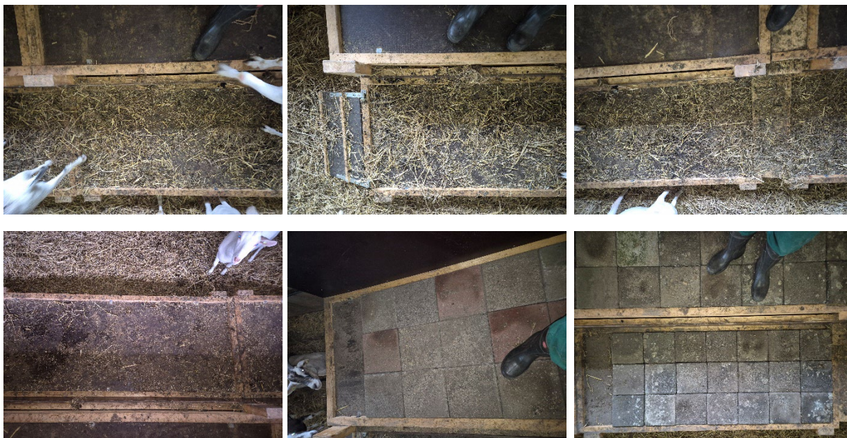
Foto 8 Platformcondities op 23 augustus, na schoonvegen/schoonkrabben en vervolgens na het leggen van stoeptegels.
