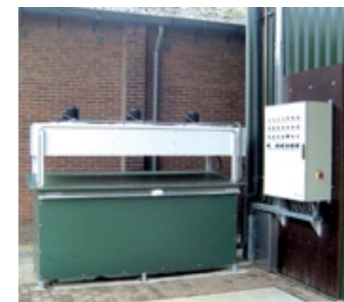
▲ De condensor moet eenvoudig koude lucht aan kunnen zuigen.
