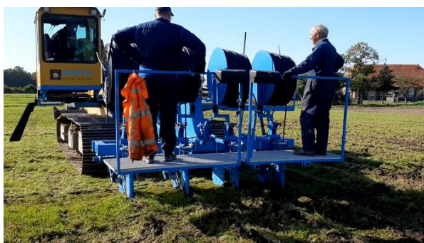
Afbeelding 1 Aanleg ondergrondse druppelirrigatie.
