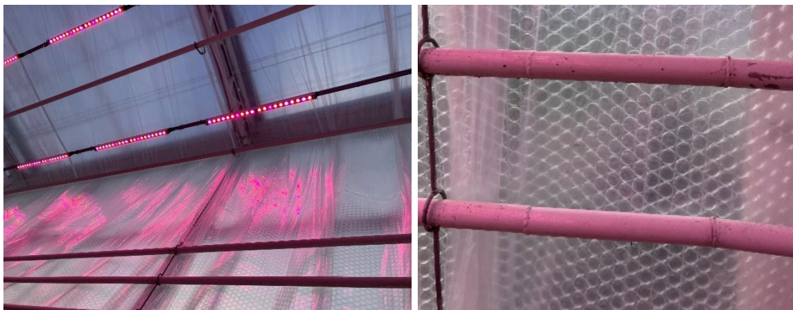
Figuur 1 Links aanblik van het ongeperforeerd folie ("schermlaag 5") en rechts detail van de gevel bedekt met het noppenfolie ("schermlaag 6").
