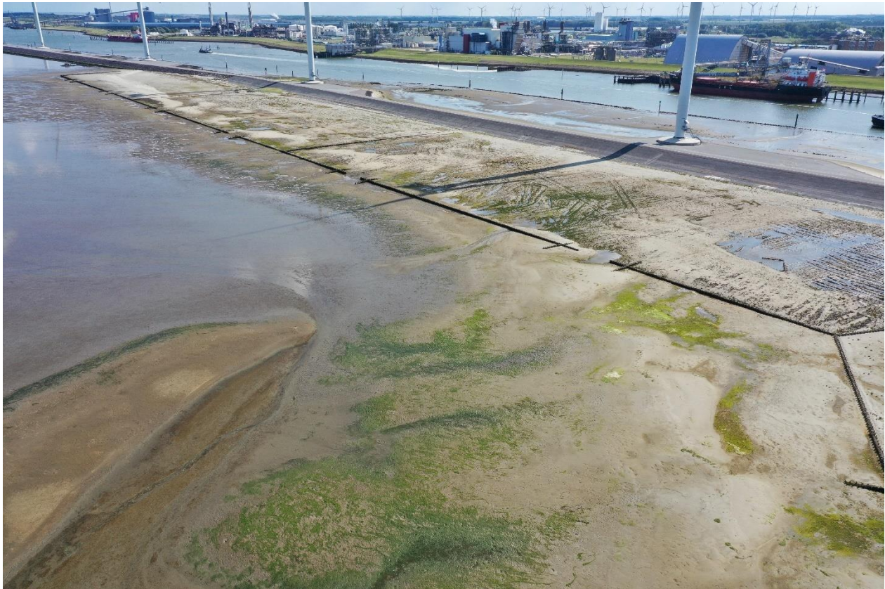
Figuur 2.2 Pionierkwelder Delfzijl aangelegd door sedimentsuppletie foto door Eemsdelta Drones
