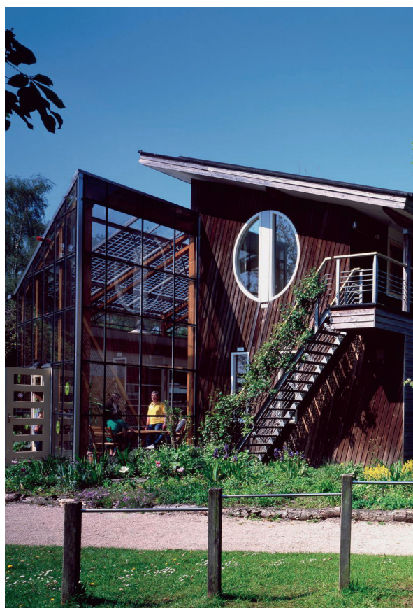
Kennis- en praktijkcentrum van De Plaatsen.
