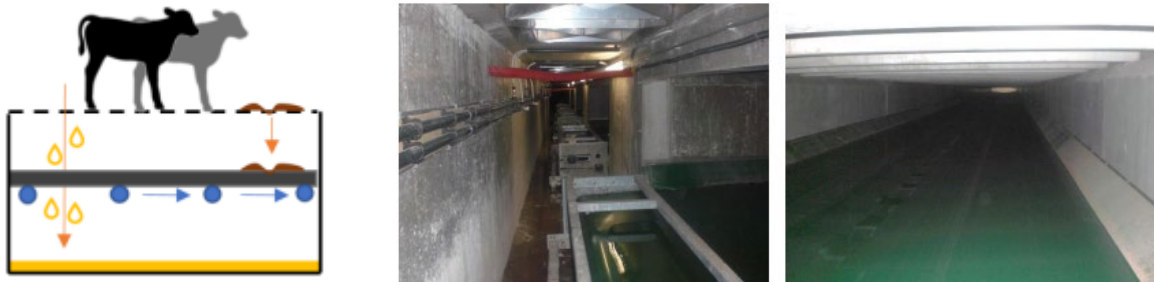
Figuur 2 Visualisatie van het systeem (links) (Van Boxmeer et al., 2023b). V-vormige mestband, opvangruimte van urine en feces (midden) en mestband onder roostervloer (rechts) (Mosquera et al., 2019).
