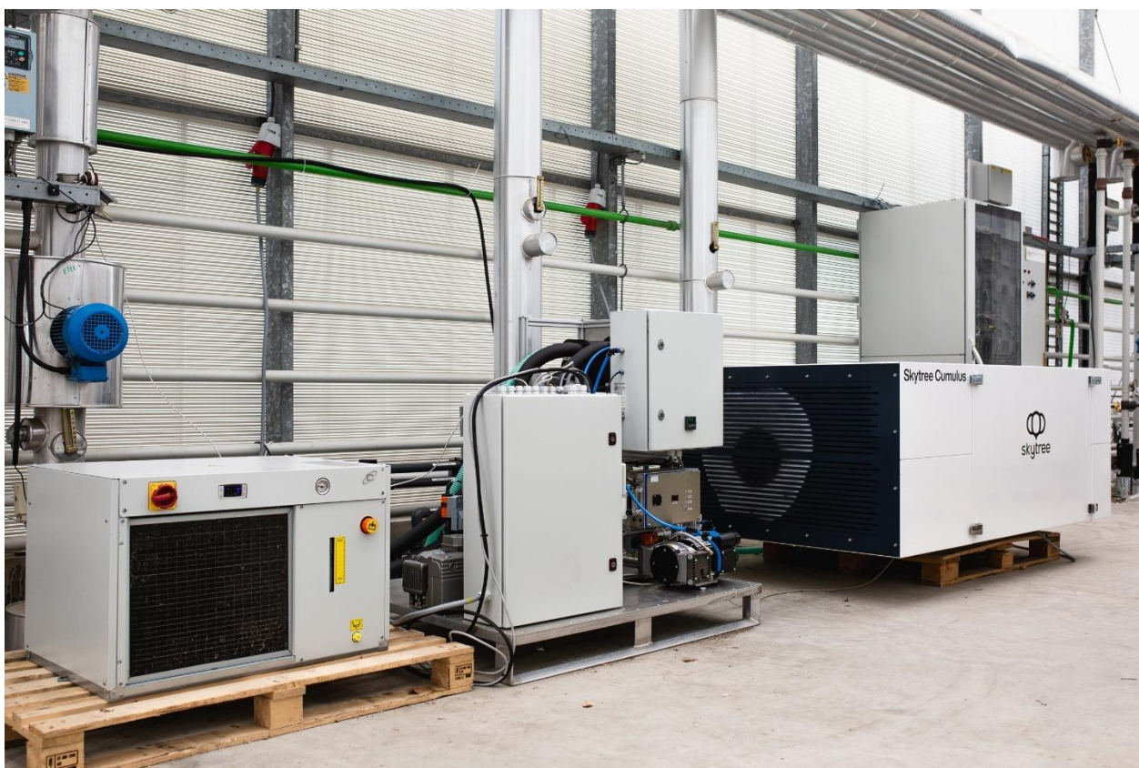
Figuur 2 De bètaversie van de Skytree Cumulus. Links is de apparatuur zichtbaar die deel uitmaakt van de Control unit en rechts staat de Main unit die omgevingslucht aanzuigt. (Foto door Skytree.)
