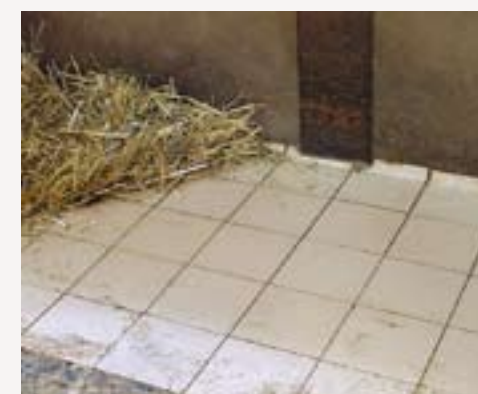
Een voergang met een te smalle strook tegels wordt toch nog aangevreten.
