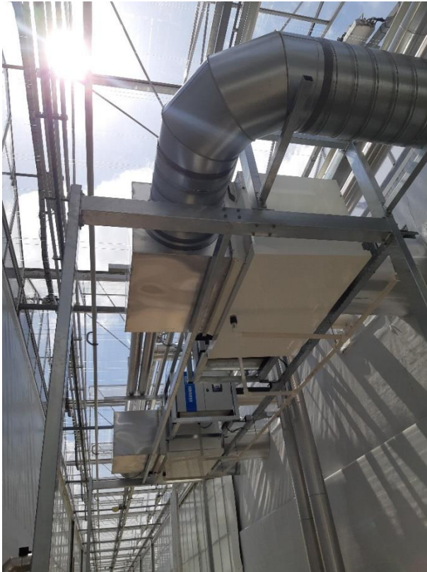
Figuur 1 Achterkant van het compartiment met zicht op de 2 koelmachines; tussen de twee koelmachines zijn 2 ultrasoonbevochtigers gemonteerd.
