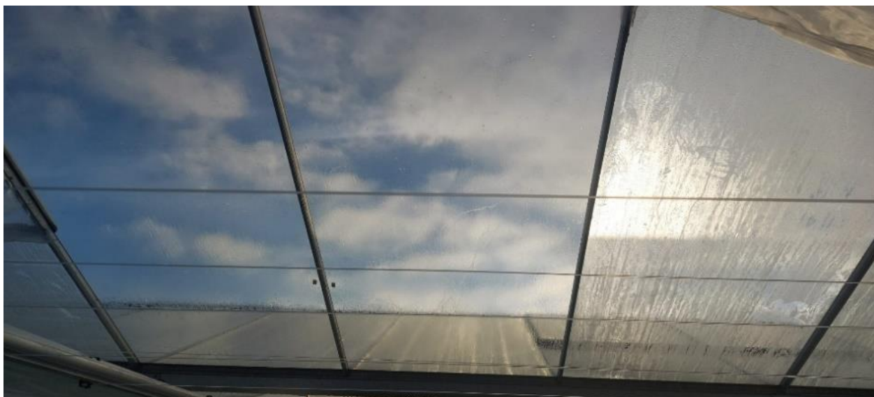
Figuur 1 Het verschil tussen twee ruiten voorzien van hydrofiele coating (links) en een niet behandelde ruit (rechts).
