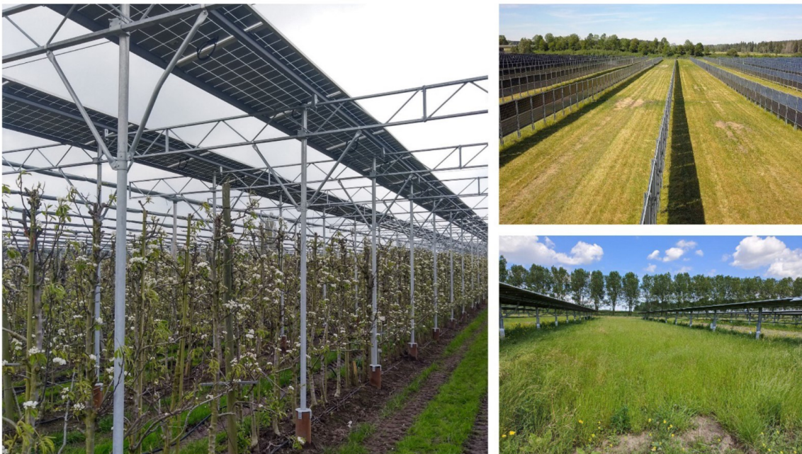
Voorbeelden van agri-PV systemen. Links: overkapping van zonnepanelen boven peren. Rechts: rijen panelen waartussen geteeld kan worden. Rechtsboven: verticaal geplaatste panelen, rechtsonder: panelen die met de zon mee kunnen bewegen (tracking systemen).
