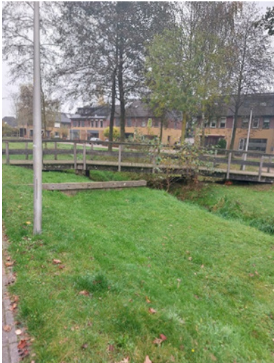
Figuur B1.46 Wadi met afwatering naar de beek Foto: Joyce Zwartkruis.
