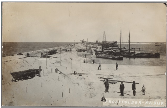
Figuur B1.11 De aanleg van de Proefpolder Andijk Bron: Zuiderzeecollectie (2023), foto: Pieter Jonker.
