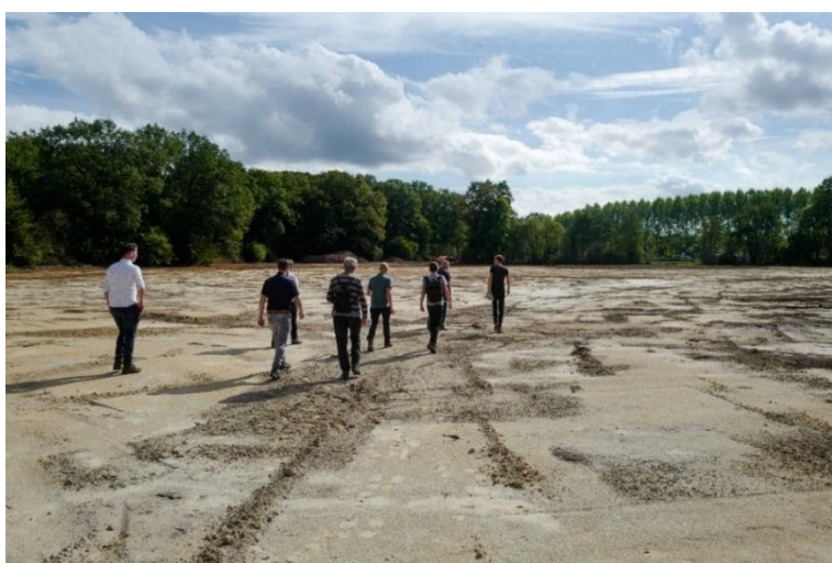
Figuur 8 Ter bestrijding van de verdroging is op landgoed 't Medler een beek dichtgeschoven en een laagte gecreëerd waar vee op kan grazen en die alleen functioneert als afwateringsmiddel bij hevige neerslag.
