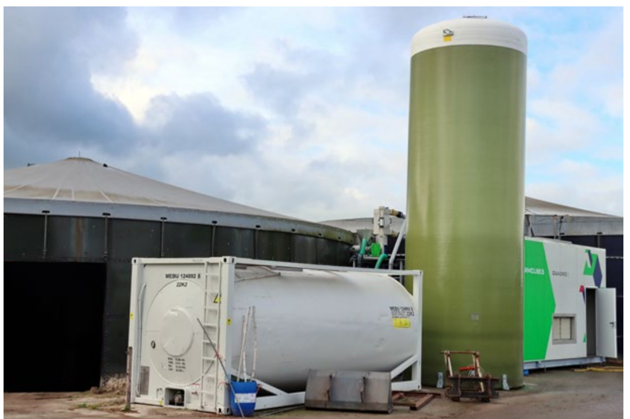
Met de stikstofstripinstallatie beperkt Kees Jan Van Wijk zijn verplichte mestafvoer.
