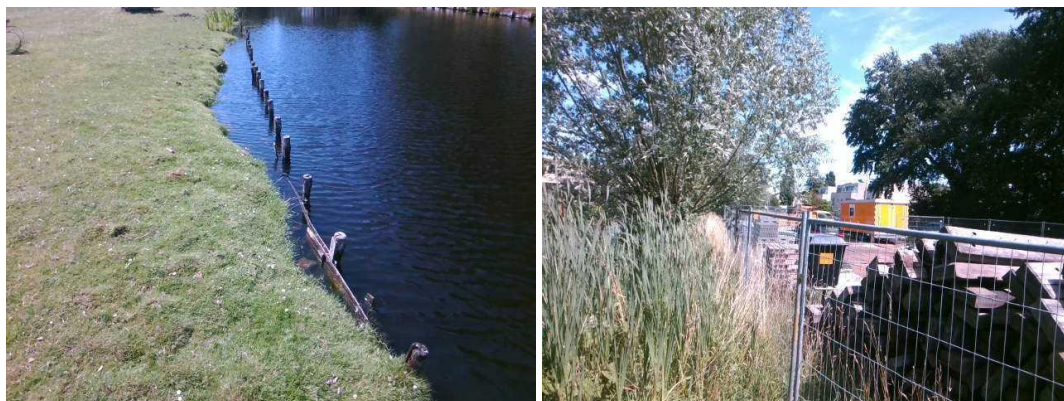
Links: onbegroeide plasberm achter de beschoeiing. Rechts: bouwwerkzaamheden op veldje langs watergang
