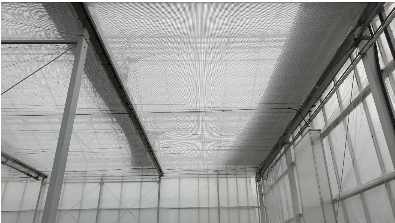
Figuur 3 Aanblik van een deel van het scherpakket bij het gedeeltelijk sluiten van het aluminium doek.
