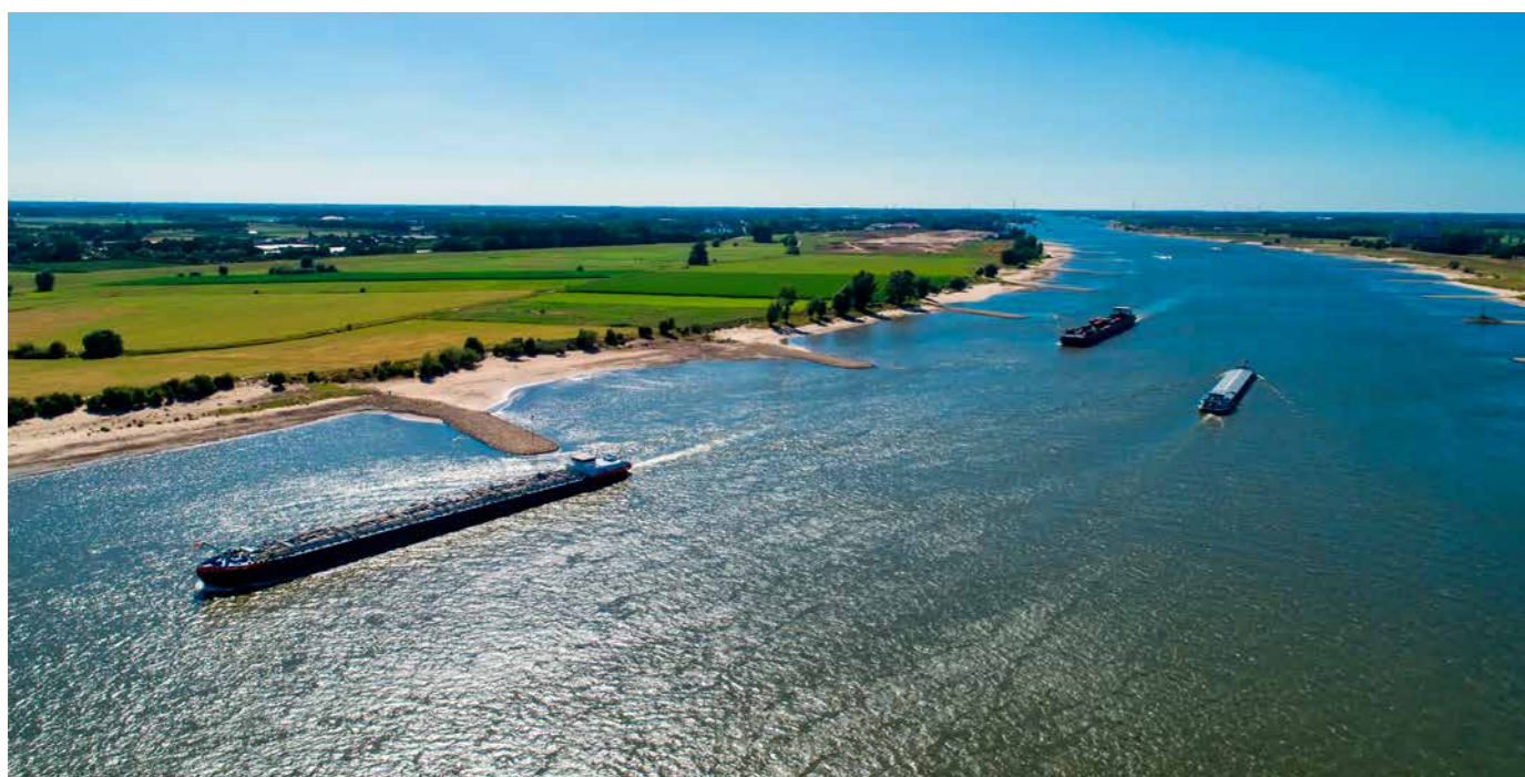
Figuur 4: Door het aanleggen van kribben in de geul en dijken om de rivier ligt de rivier vast op één plaats, een natuurlijke rivier is hier niet voor gemaakt. (foto: shutterstock)
