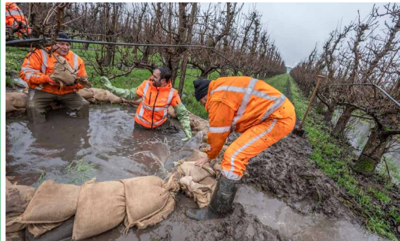
Figuur 14: Het 'opkisten' van een zand meevoerende wel. Hierdoor wordt tegendruk gemaakt tegen de kweldruk uit de wel. Deze zand meevoerende wellen komen vooral vaak voor waar oude zandige rivierafzettingen in de ondergrond liggen. (foto: waterschap Rivierenland)
