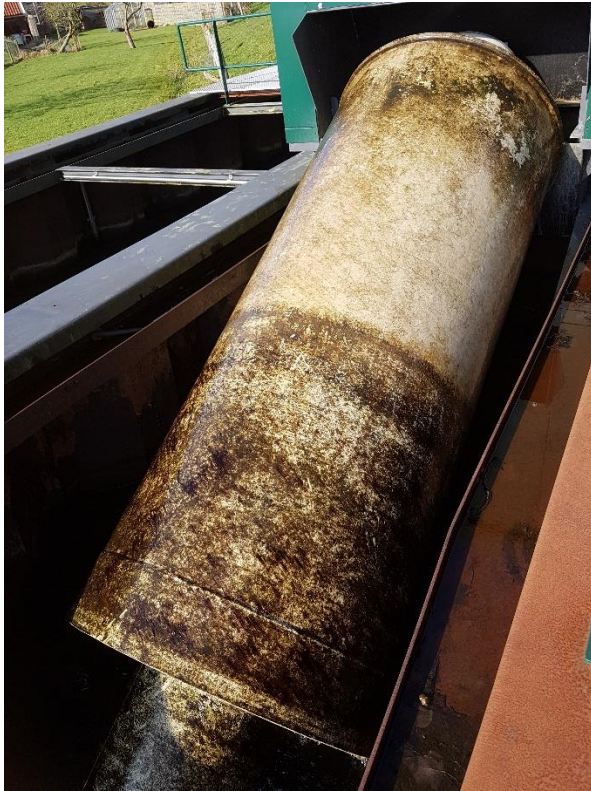
Figuur 3.23 Opvangbak met vijzel en retourstroming zijde Weerribben, naast gemaal Stroink (Waterschap Overijsselse Delta)
