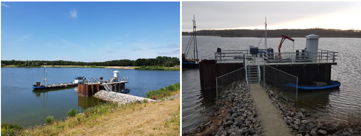
Figuur 3.22 Opvangbak met pomp en retourstroming aan de IJsselmeerzijde bij Den Oever (Rijkswaterstaat Midden Nederland)
