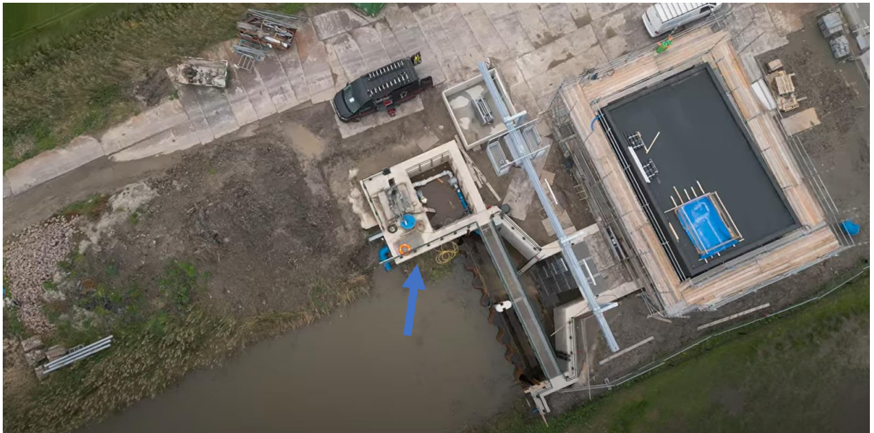
Figuur 3.10 Opvangbak vispassage -blauwe pijl bij gemaal Oudenhoorn in aanbouw (Waterschap Hollandse Delta)
