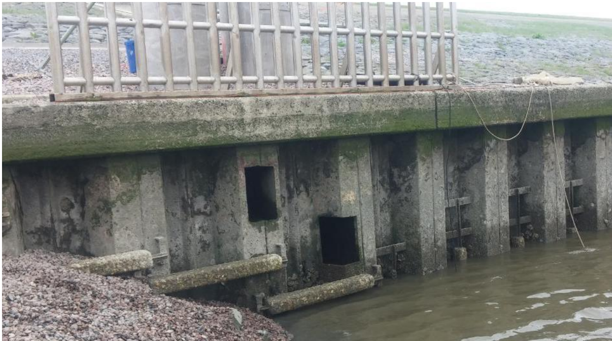
Figuur 3.4 Roptazijl buitendijks, gaten lokstroom en ingang naar opvangbak van de vishevel (Kalt & de Vries, 2014)
