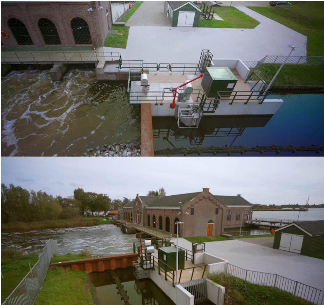
Figuur 3.25 Opvangbak met pomp en retourstroming zijde Rijnlands boezem, naast gemaal Spaarndam (Hoogheemraadschap van Rijnland)
