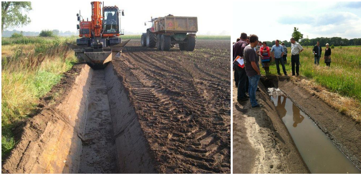
Figuur 4 Foto's infiltratiegreppel die gemaakt zijn in het noorden van Friesland (noordelijke kleischil). Foto's verkregen van Jan Roelsma (Wetterskip Fryslân).
