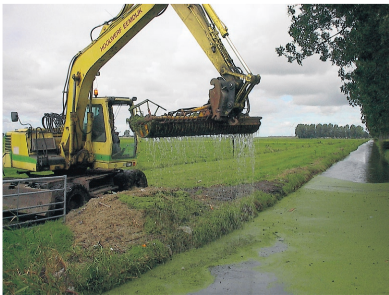
De technieken om eendenkroos uit de sloten te scheppen zijn nog beperkt.
